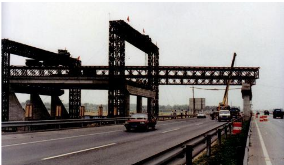
由河北省公路工程局三处四工区承建的保津高速公路跨京石立交桥正在紧张施工(1997)
