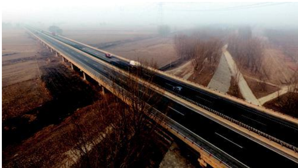
雄州特大桥现状 摄影 肖国生
