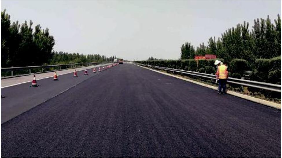
养护公司承建的大广项目罩面工程竣工(2017)
