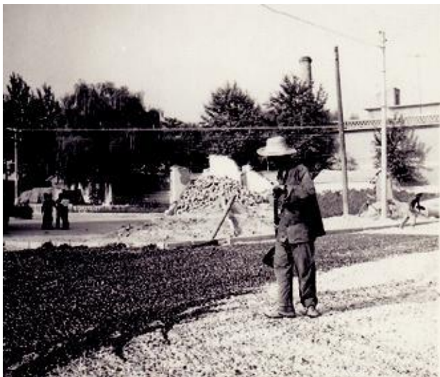
河北省公路工程队一工区在津保公路用手工摊铺沥青贯入式路面 (1958)
