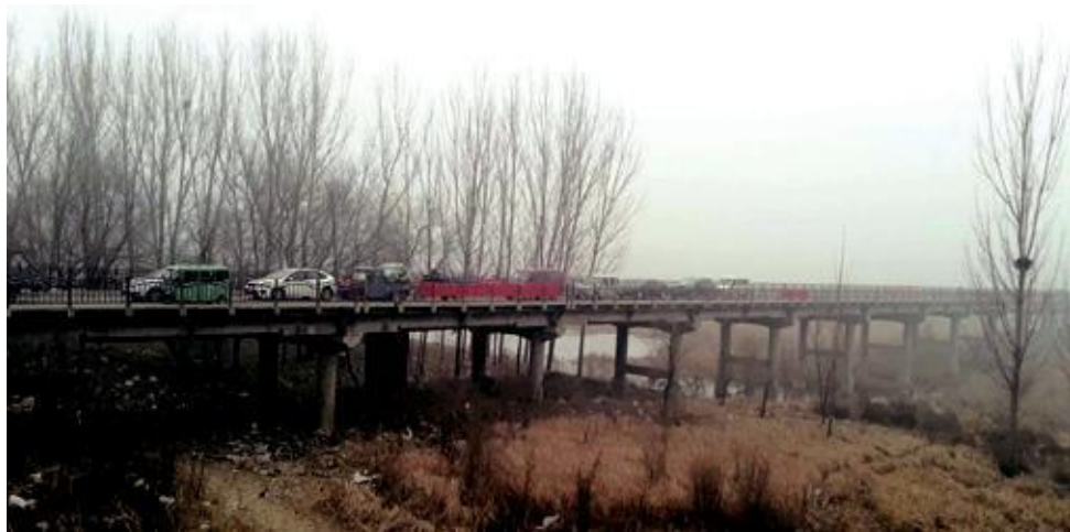
白沟大桥现状——李想拍摄于 2017 年 12 月
