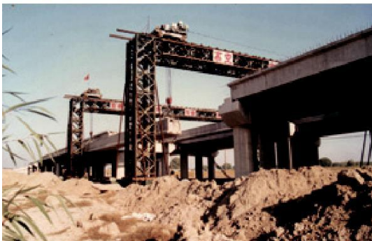
雄州特大桥施工(1996)
