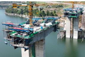
目前，西南区域总部重庆忠县项目东溪河大桥进入主桥悬臂浇筑施工阶段。该桥根据施工顺序共分为墩0号段、悬臂浇筑1-17段、边跨合龙段、中跨合龙段18号段和边跨现浇段19号段。已浇筑完成左幅4号节段，右幅7号节段，下一步将有针对性地开展多种措施，加快项目建设进度。（郭星星）
