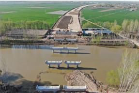
近日，第六公司省道S237项目老沙河大桥下部构造施工完美收官，将进入上部结构施工。由于老沙河水位超高，项目部与河道管理部门及时沟通，采取钢板桩围堰作为基坑支护，并编制专项施工方案通过专家论证。为保证桥梁施工质量安全，施工前组织作业班组进行安全技术交底，安监部和技术人员现场盯防，保证了该桥的顺利施工。（马立彬、段鹏）
