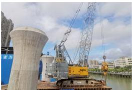
近日，保通公司船厂跨江桥梁项目南岸钢桥桥开始搭设，栈桥结构设计呈“T”型，长96米、宽6米，采用75T履带吊振动法进行钢管桩沉桩施工。施工主要分为钢管桩施工、桩顶分配梁、贝雷片安装、分配梁拼装等三部分。钢栈桥的架设将加快大桥的建设速度，为后期主桥跨河顶推施工奠定良好的基础。（赵振兴）
