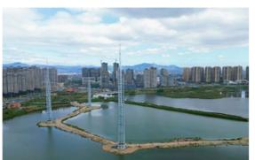
近日，第四公司集作民主路项目桥塔拉索安装顺利进行。桥塔拉索采用直径5毫米的低松弛高强度平行镀锌成品索，横桥向单侧共布置18对斜拉索，双侧为36对拉索，即全桥共72根拉索，单根最大长度约为106.6米，根据索力的不同，索桥采用了两种规格的拉索。（王胜利）
