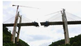
近日，随着最后一节钢箱梁吊装拼装完成，保通公司船厂跨江桥梁项目大桥主拱钢箱梁顺利实现合龙，标志着大桥整体施工还出了关键性的一步，为完成通车任务奠定了坚实基础。主拱部分采用钢箱梁形式，共划分9个浇筑阶段，运输到现场后拼装成4个大节段，分四次吊装完成。本次吊装合龙段长为40米，重105吨。（赵振兴）
