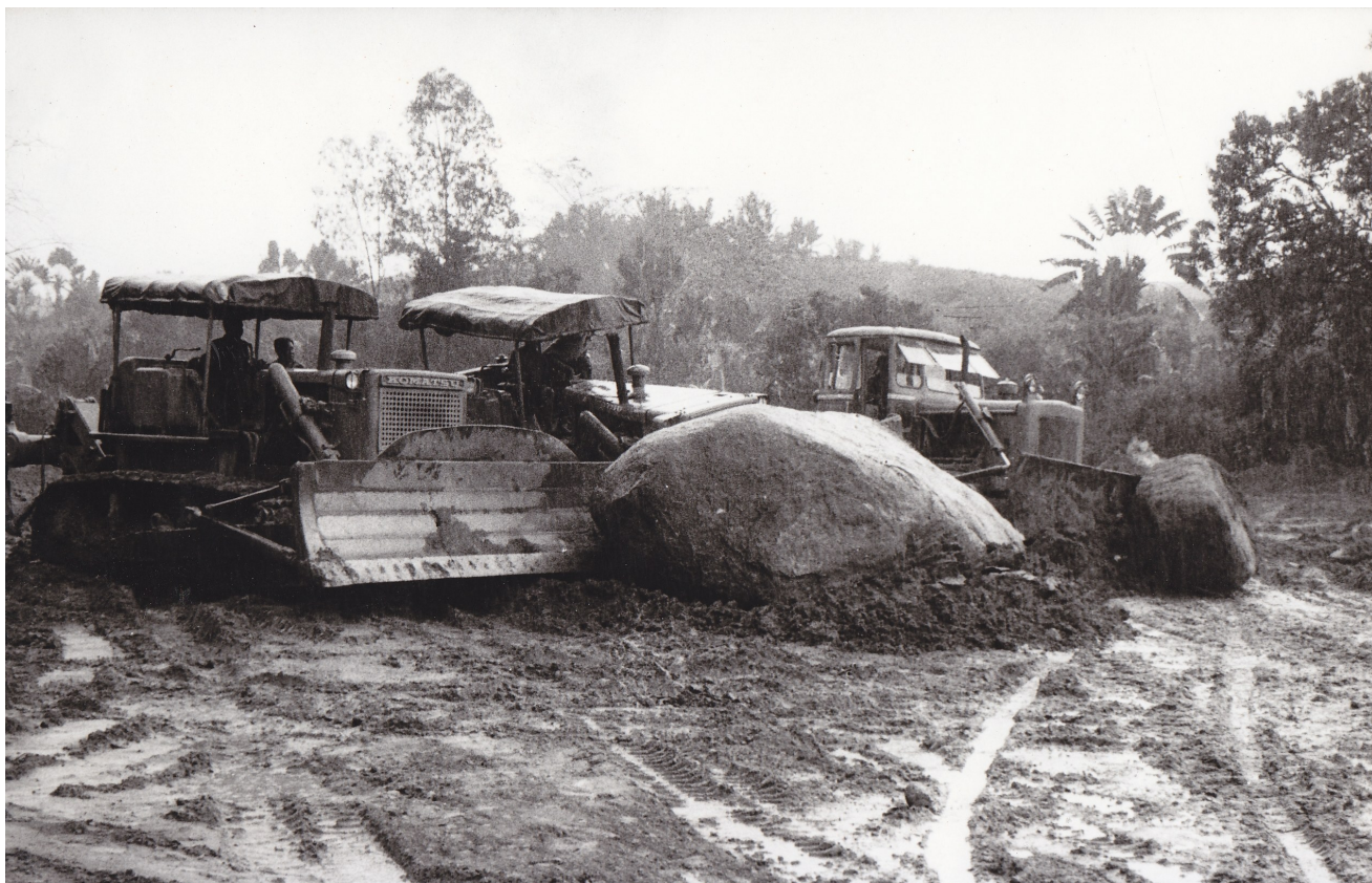
工人在马达加斯加2号公路用推土机排除工地上的巨石(1981)
