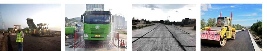
近日,山东分公司枣庄峰地区项目仙坛南路路基基层水稳全线摊铺完成,同时也打响项目大干一百二十天的第一枪。仙坛南路道路等级为市政主干道,全长1740米,主路面宽22米,项目部对施工配合比、施工方案进行严格审核,从各个环节进行严格控制,并对施工人员进行安全教育和施工技术交底,确保基层水稳摊铺过程的顺利进行。(钱伟)
