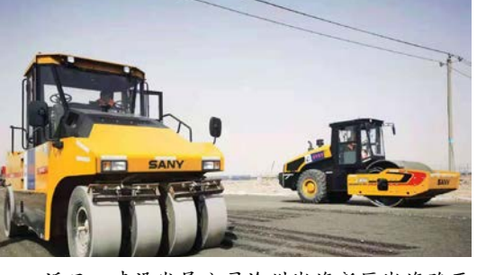
近日，建设发展公司沧州渤海新区渤海路西延工程（旭阳路至307国道）进行了水稳层摊铺
