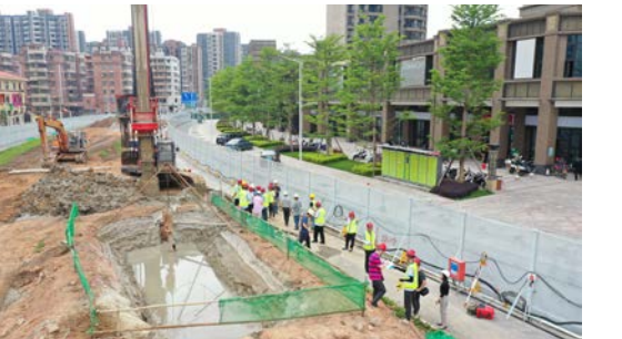
3月19日上午9时，保通公司船厂跨江桥梁项目首根桩基顺利开钻，拉开了全线控制性工程
