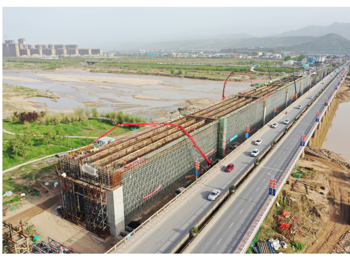
4月16日下午 17 时, 随着 3 台泵车将混凝土徐徐送入模, 山东分公司宝鸡峡锦渭河大桥第三联第三段混凝土浇筑正式开始。经过 33 小时的施工, 4 月 18 日凌晨 2 时, 顺利完成 1720 方混凝土浇筑任务。
