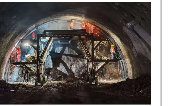
近日，西南区域总部富罗项目大寨隧道开挖支护作业进入攻坚阶段。现场严格落实开挖支护专项方案，精准把控爆破参数、初支喷锚工艺，同步强化围岩变形监测，确保每一道工序符合规范要求。通过优化班组设置、加密现场巡查频次，保障开挖支护施工连续高效推进。(蔡润杰)
