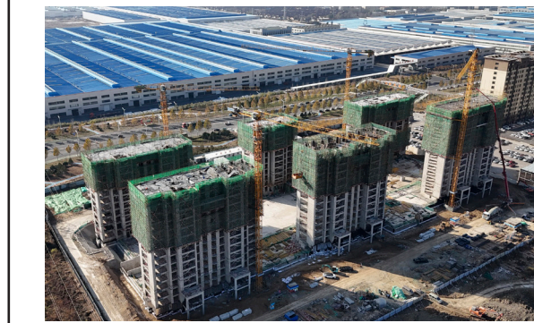
近日，山东分公司（基础公司）临朐棚户区项目正全力推进主体工程施工。现场，塔吊林立，机器轰鸣，各项工序紧密衔接，六栋住宅楼主体结构施工均已进入十层以上阶段。下一步，项目部将继续紧盯进度与品质双目标，加强全过程管控，确保工程进展稳步推进。(田玉杰)
