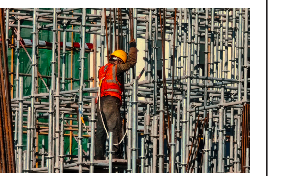
近日，第四公司信阳产业园项目特种设备检测中心主体结构施工已全面完成，地上主体结构施工已全部完成。当前，施工人员正严格按照规范进行一层6-10轴内架搭设。(张世杰)
