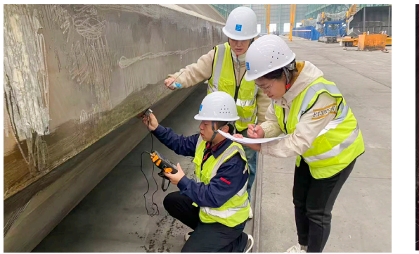
近日，在平山县城南延河大桥桥现场，科技发展公司检测人员手持数字超声波检测仪，对景观装饰的钢结构焊缝质量进行精密检测。A型脉冲反射法及数字化的检测手段，不仅提升质量检测精度，更为桥梁装饰的整体美观与结构安全提供了可靠技术保障。(杨木宇)
