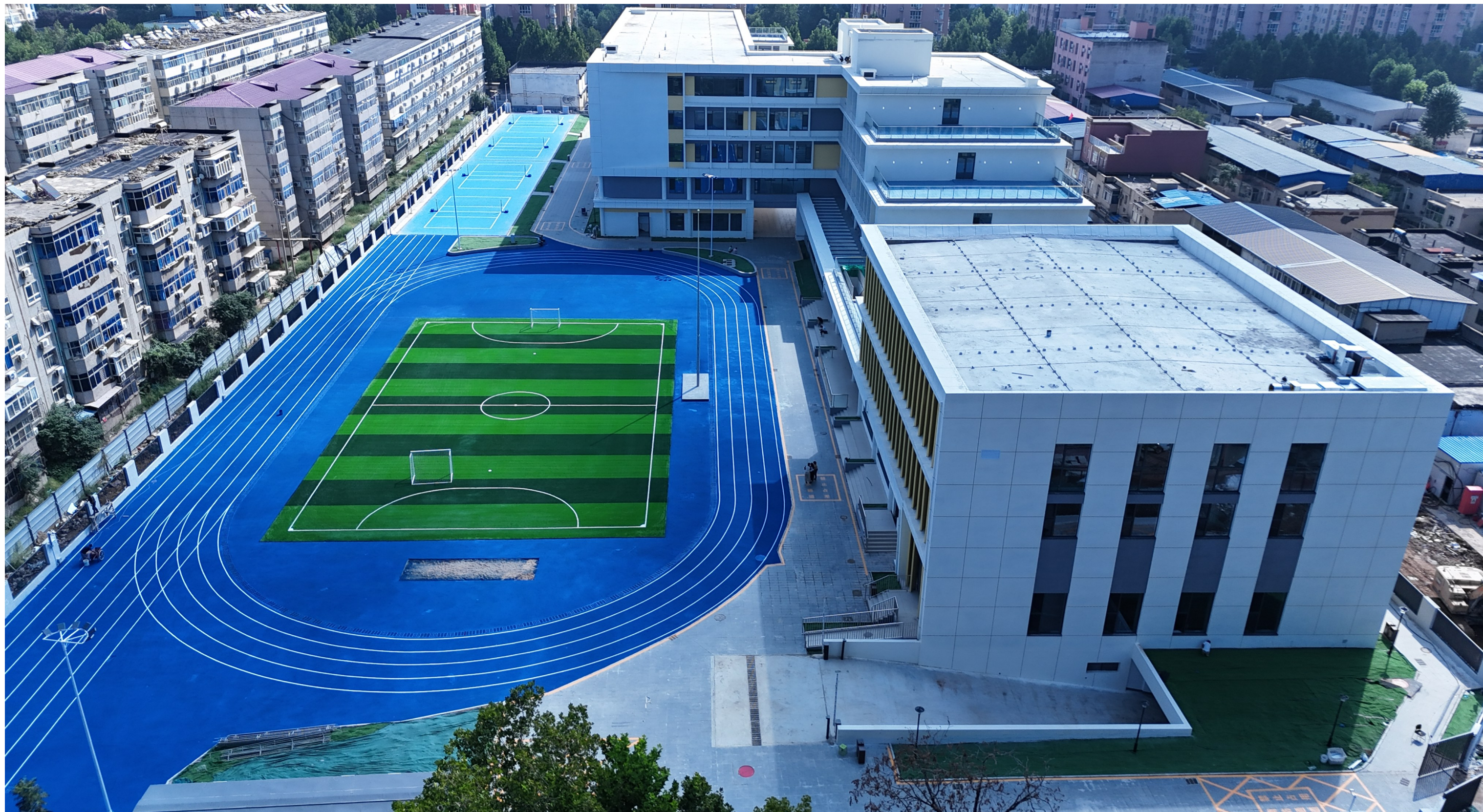
中国·河北省·石家庄市 北杜城中村改造配建学校项目
